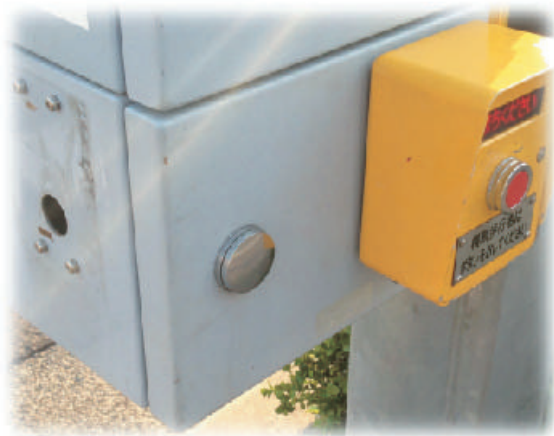
押しボタンの取付位置を元の位置(左の穴)から90度変更。
