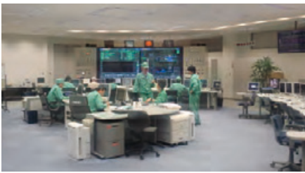
▲坂出火力発電所視察(5/31)
