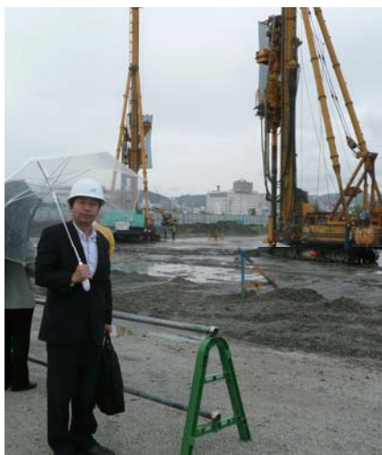
▲5/23 朝日町の工事現場を委員会視察。
